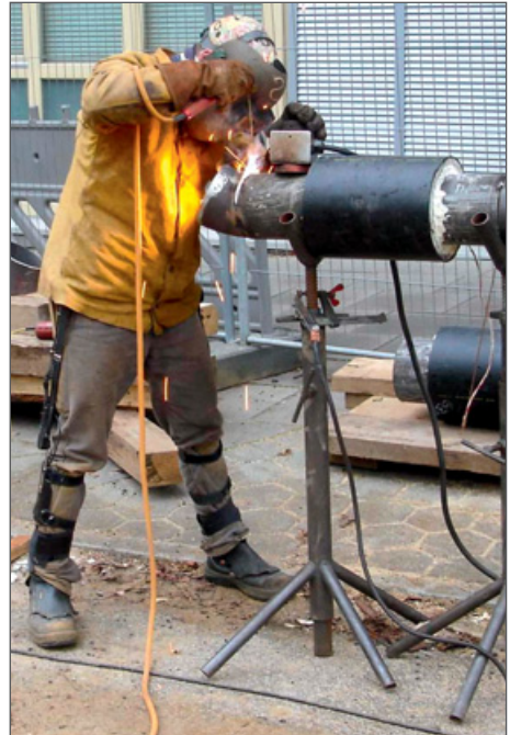
Arbeitshöhe: gute Lösung, Hochlagerung ermöglicht aufrechtes Arbeiten
